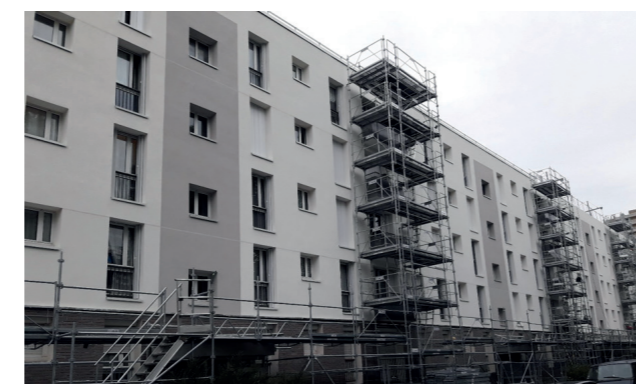
LES TRAVAUX D'ISOLATION THERMIQUE PAR L'EXTÉRIEUR AVANCENT ! (FAÇADES AVANT ET ARRIÈRE DE TASSIGNY)
