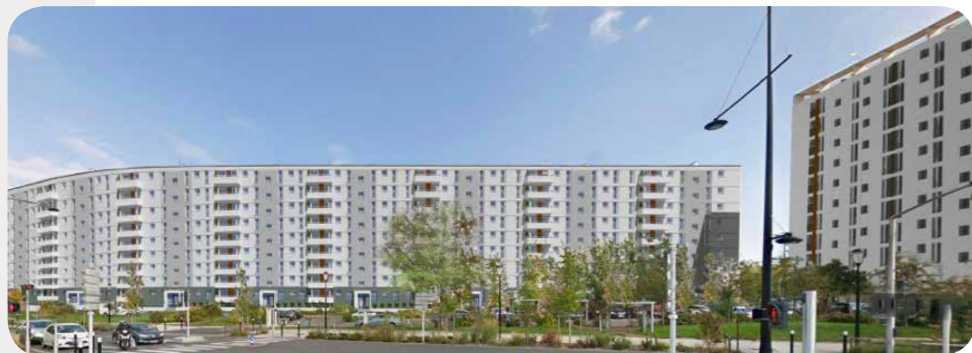
VUE DEPUIS LA DIVISION LECLERC SUR LA FUTURE RÉSIDENCE DE LA PLAINE III APRÈS LES TRAVAUX.
