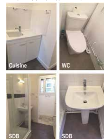
TRAVAUX RÉALISÉS DANS LE LOGEMENT TÉMOIN
